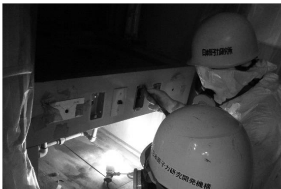
フードの解体撤去
