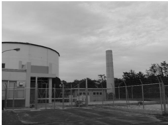
15 トンクレーン室の建家解体後
