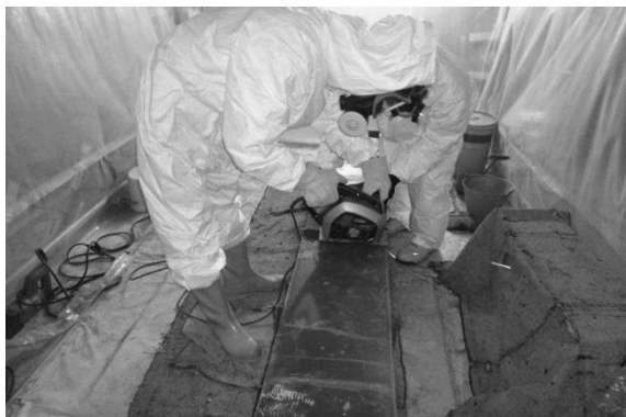
炉室内細断用 GH での細断
