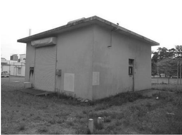
非常電源室の建家解体前
