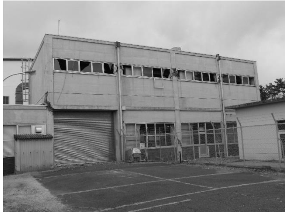
15 トンクレーン室の建家解体前
