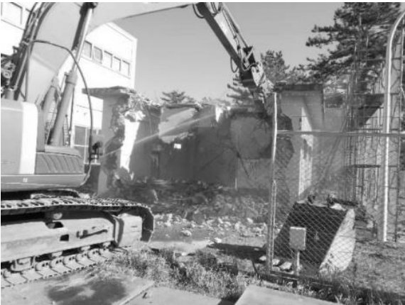
非常電源室の建家解体
