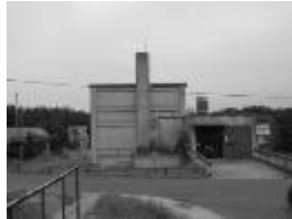
ウラン濃縮研究棟
