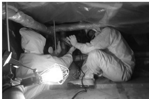
排水配管の解体撤去
