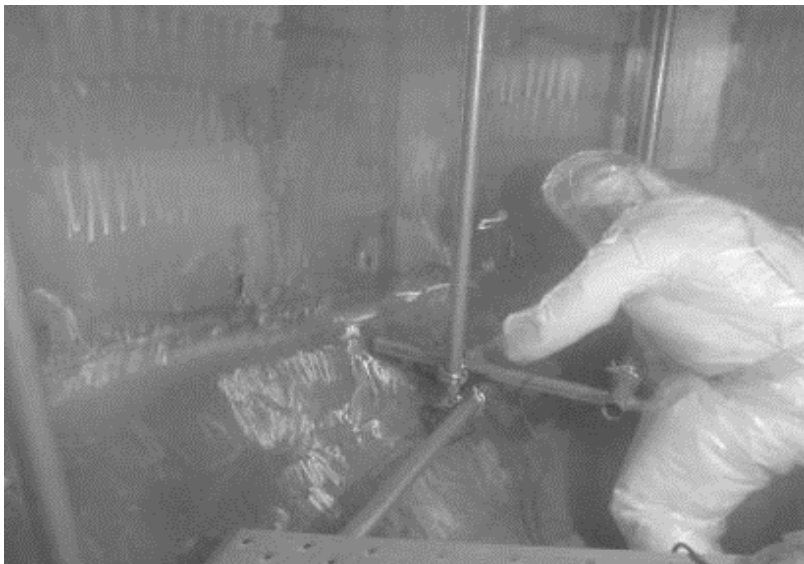
図 8.1.2-5 LV-1 内の除染作業の状況
