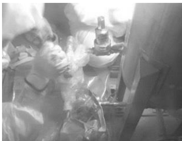
図 8.1.3-3 調整液タンク及びポンプの撤去状況
