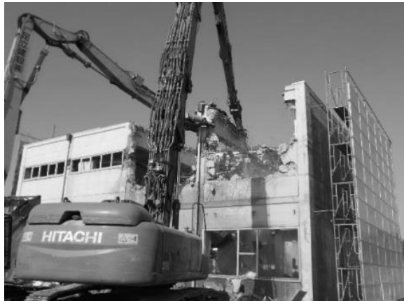
15 トンクレーン室の建家解体
