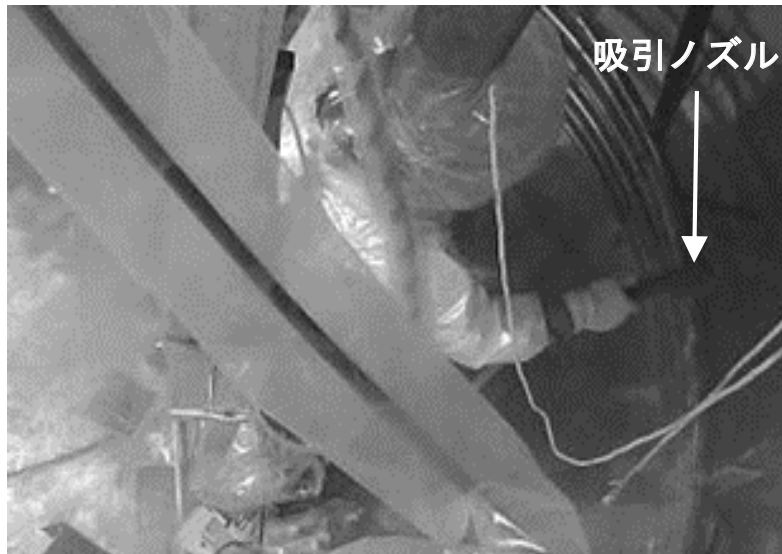
残渣回収作業
