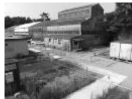
モックアップ試験室建家
