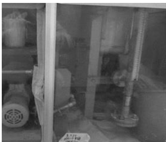
図 8.1.3-3 調整液タンク及びポンプの撤去状況
