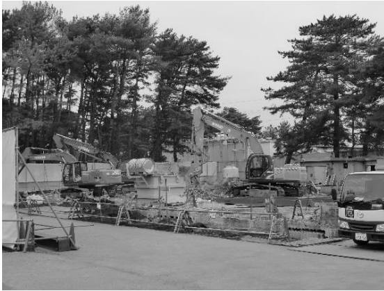
基礎部の解体
