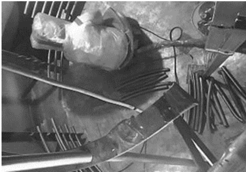
図 8.1.2-4 LV-1 内配管の撤去作業の状況
