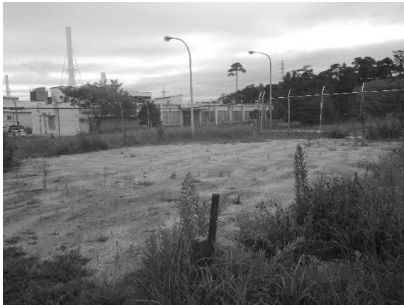
非常電源室の建家解体後
