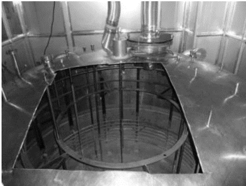
図 8.1.2-2 今年度の解体作業前の LV-1 の状況
